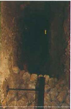
壁面に築かれた壕風よけの壁
